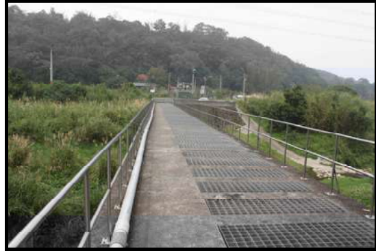
幹線 0k+050 過水橋(第一工段)
