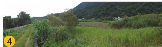
4 2號沉澱池與道路間為泥土路
