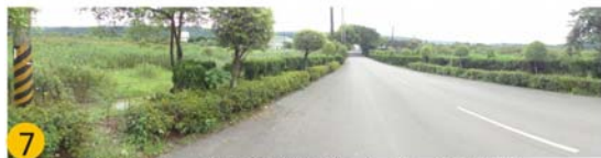
7 3號沉澱池東側與道路有高低落差
