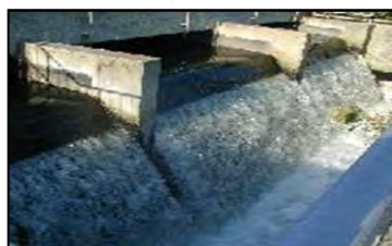
防砂/治水堰堤
